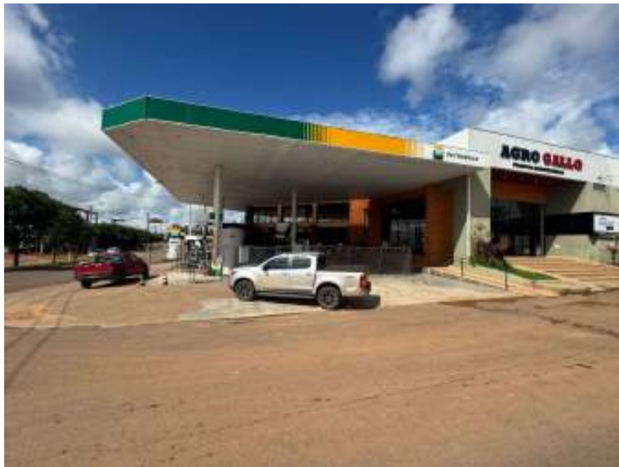
Foto 01 – Vista frontal da edificação, Av. Nilo Peçanha
