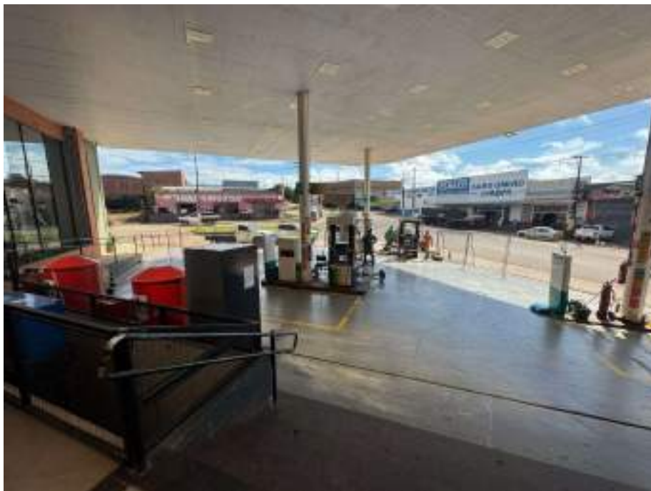
Foto 05 – Pátio do posto de combustível
