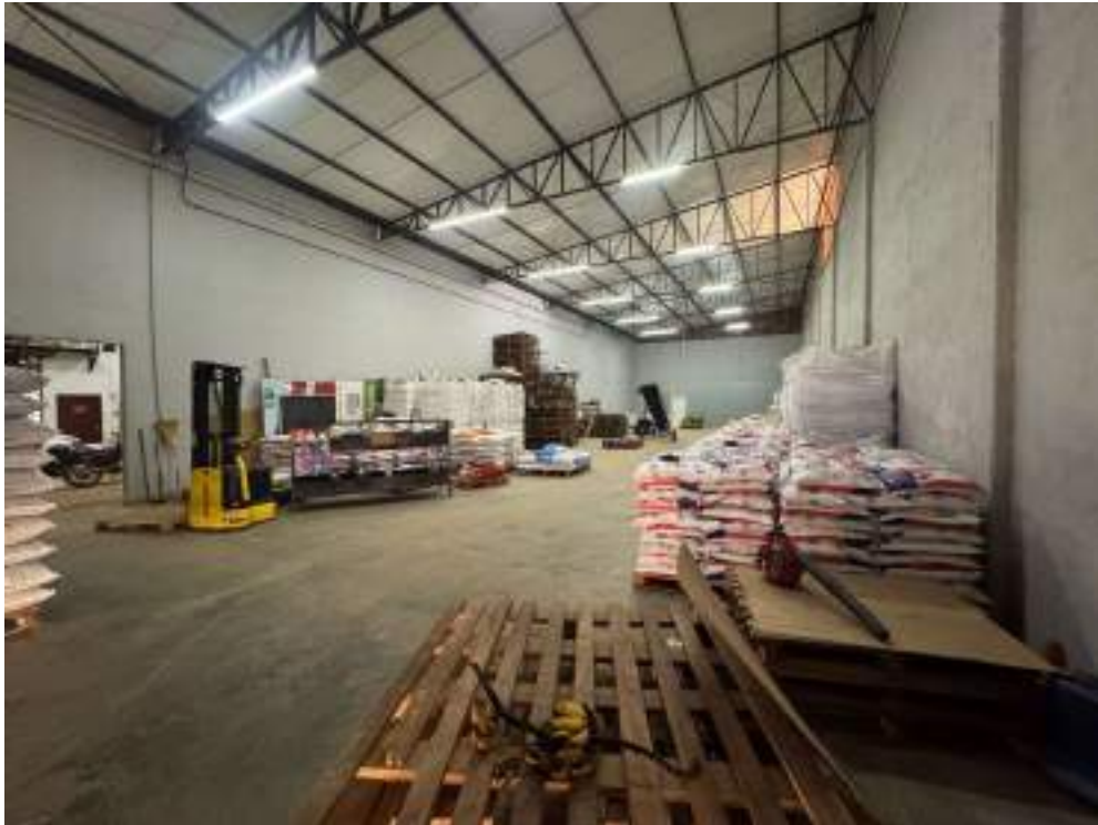
Foto 04 – Vista Interna da Edificação
