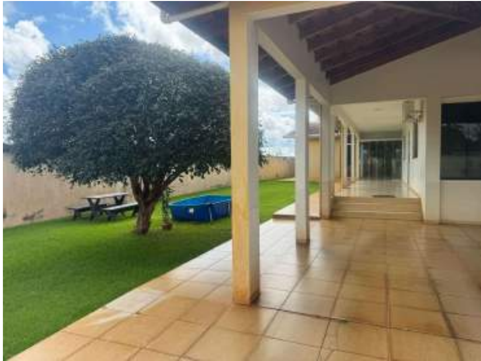
Foto 02 – Vista da Edificação
