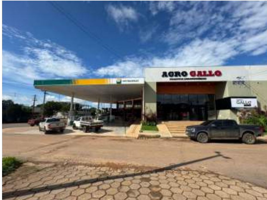
Foto 04 – Vista Frontal da edificação – Av. Nilo Peçanha
