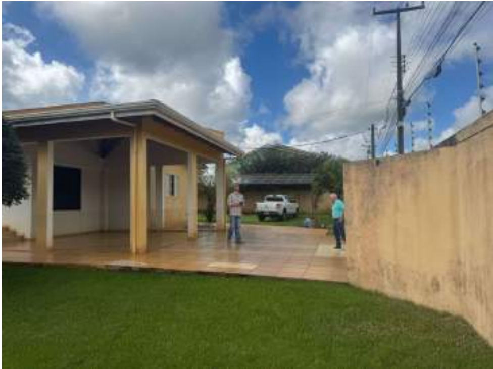
Foto 04 – Vista da Edificação
