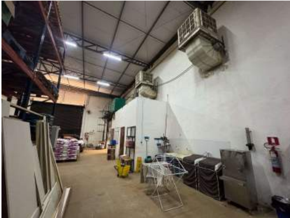
Foto 06 – Vista Interna da Edificação
