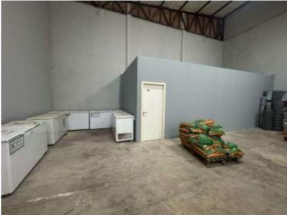
Foto 08 – Vista Interna da Edificação
