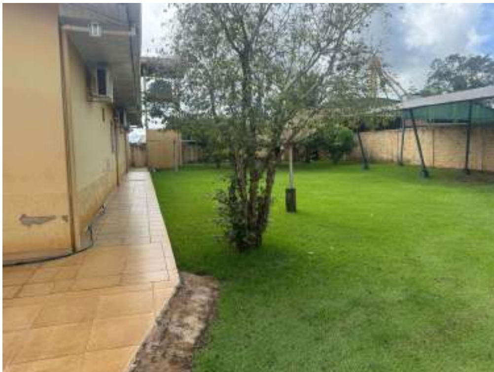
Foto 03 – Vista da Edificação
