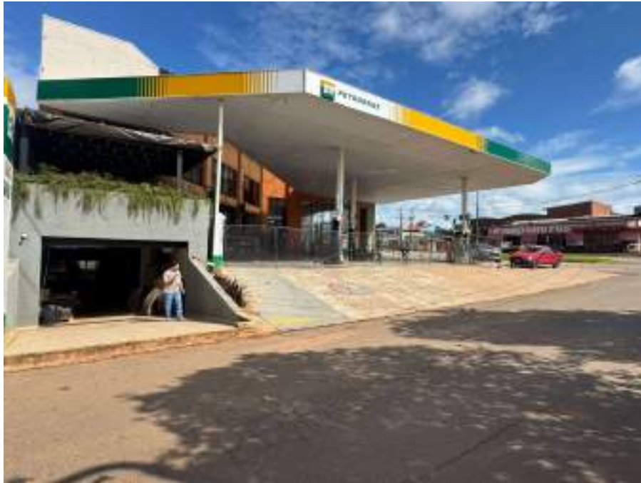
Foto 02 – Vista frontal da edificação – Av. Rondônia
