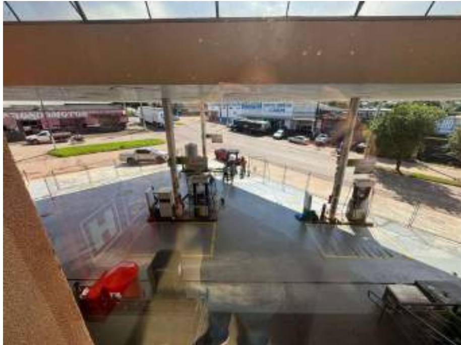
Foto 06 – Pátio do posto de combustível
