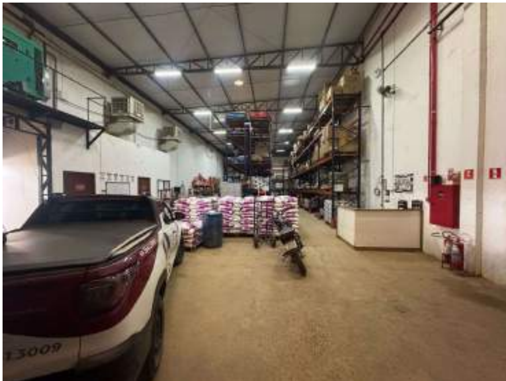
Foto 03 – Vista Interna da Edificação
