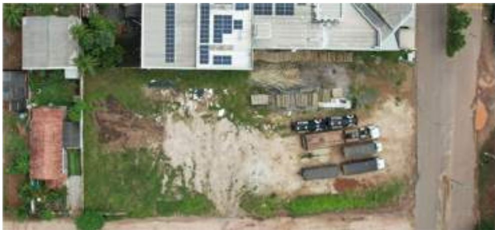
Foto 03 – Vista aérea do lote.
