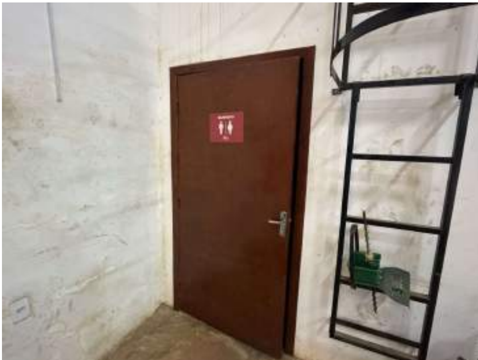
Foto 05 – Vista Interna da Edificação
