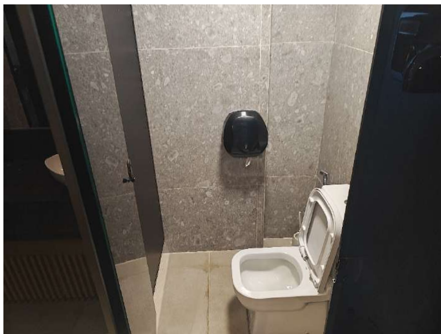
Fotografia 7 - Vista do banheiro - vaso sanitário.
