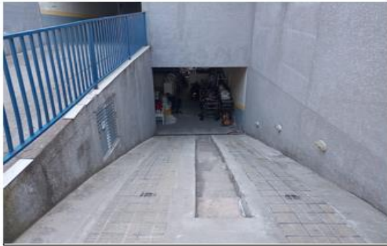
Acesso ao Subsolo (Almoxarife)
