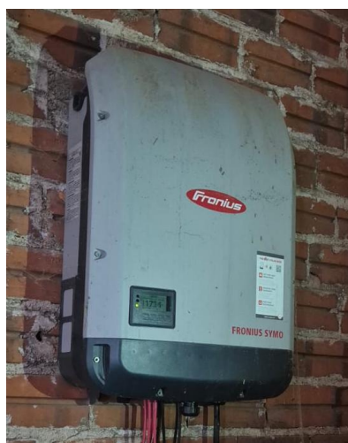
19. CONJUNTO FOTOVOLTAICO TRIFÁSICO
